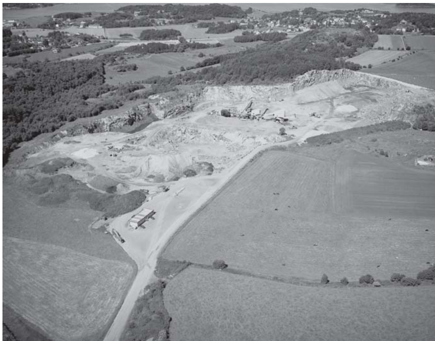
Norstone Røyneberg Pukkverk sitt anlegg på Sola nær Sandnes.
